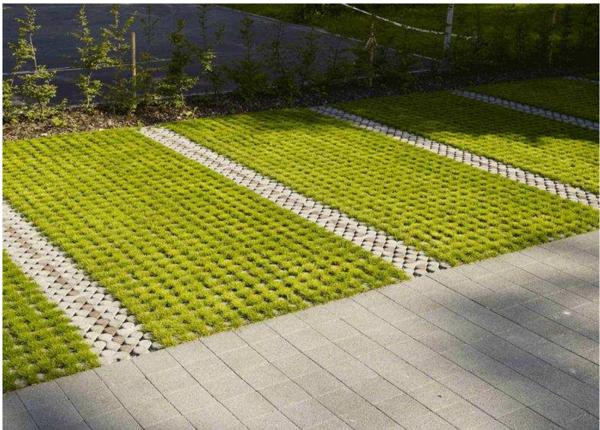
Figuur 35: Parkeerplaatsen in grasdallen
