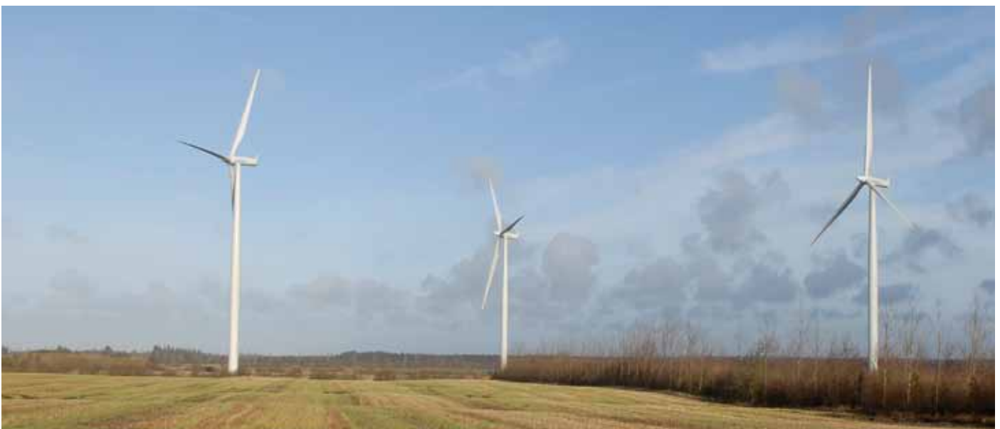
Foto 1. De næststørste vindmøller i Ringkøbing-Skjern kommune er tre 127 m høje vindmøller ved Lyngmose med rotordiameter 93 m og navhøjde 80 m. Der udføres støjmålinger på møllerne, for at verificere støjen fra store serieproducerede møller.
