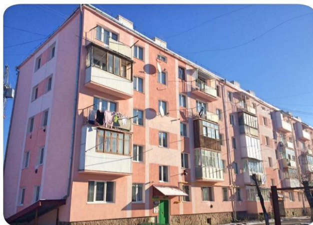
ОСББ по вул. Обліски 22А (60 квартир)
