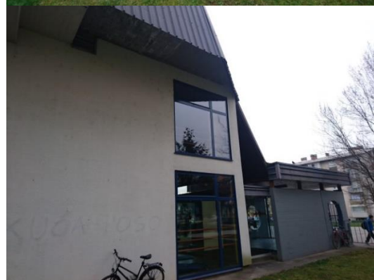
Slika 63: Neizoliran podzidek in toplotni most zaradi betonske plošče.
