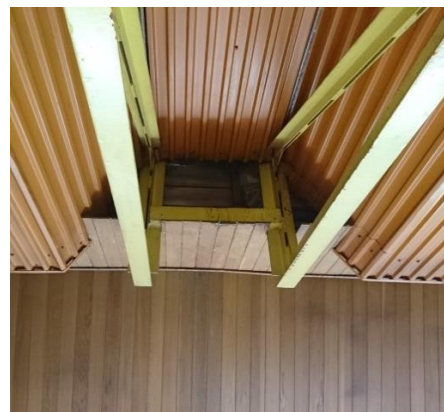
Slika 71: Podobno kot balkonske plošče, frčade in ostali gradniki stavb, ki »štrlijo« iz ovoja stavbe jih je v praksi težko in zamudno ustrezno izolirati.
