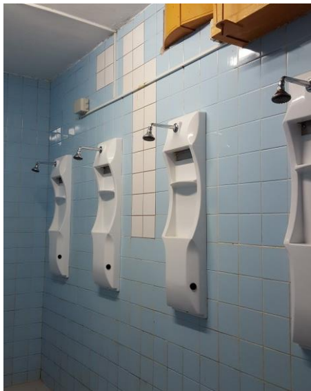
Slika 34: Tuši s senzorjem prisotnosti v ŠD in bazen v sklopu OŠ.
