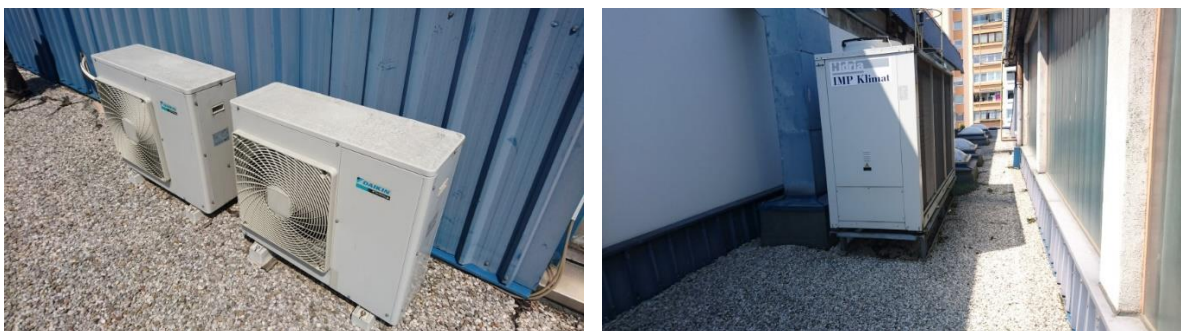
Slika 36: Hlajenje šole (levo) in hlajenje dvorane(desno).
