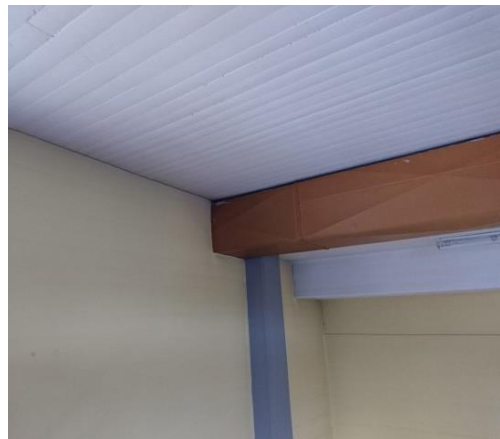
Slika 70: Prezračevalni kanal – možnost za kondenzacijo.
