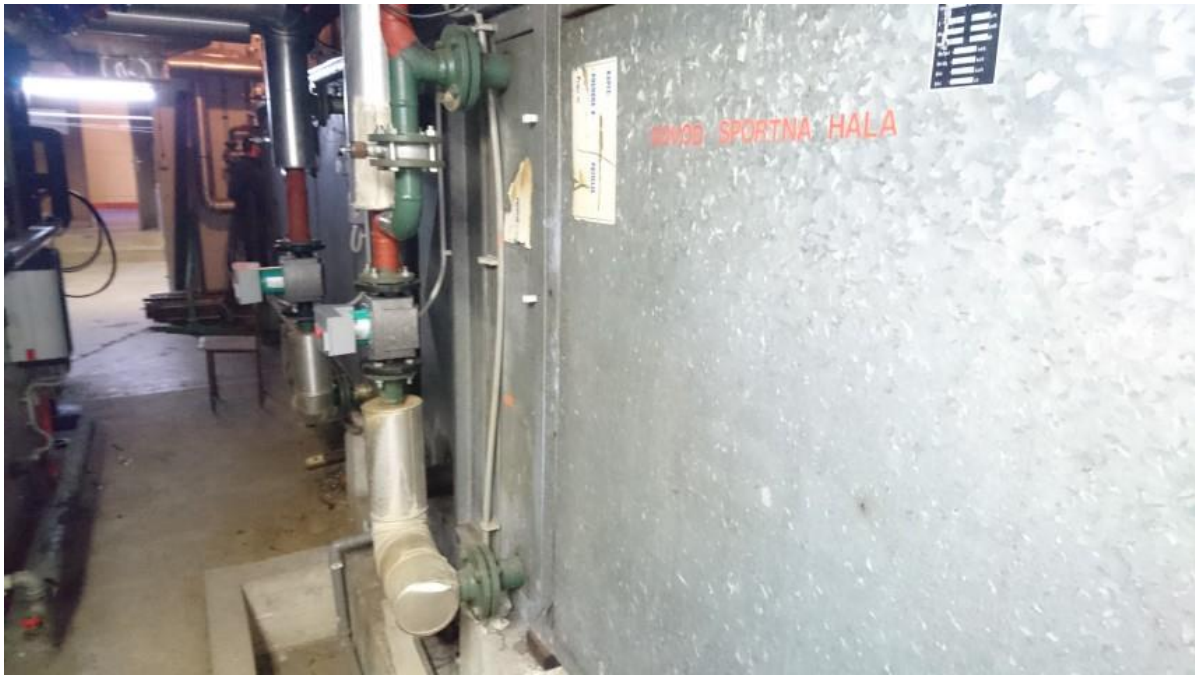
Slika 35: Klimat za ogrevanje in prezračevanje dvorane z deloma prenovljenimi elementi.
