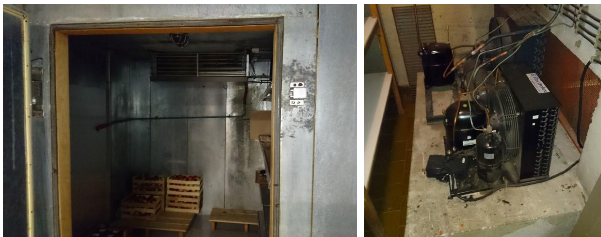
Slika 41: Hladilnica in pripadajoča hladilna naprava.
