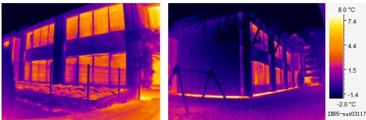
Slika 42: Termografski posnetek SZ in JV fasade.
