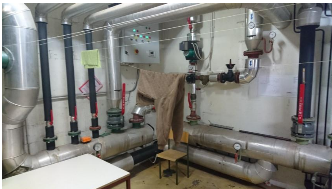
Slika 30: Razvodni sistem obložen s prvotno in novejšo izolacijo.
