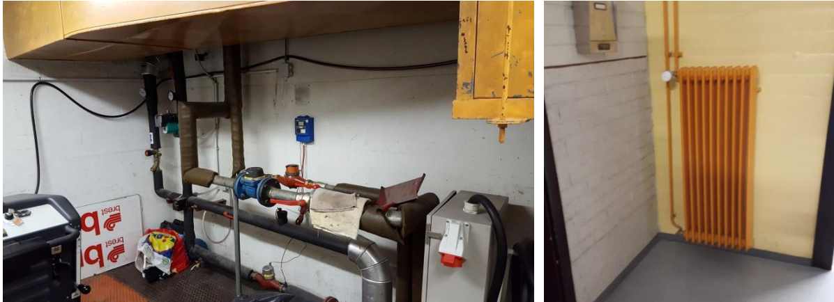
Slika 31: Toplotna podpostaja v dvorani in litoželezna ogrevala z nameščenimi termostatskimi ventili.
