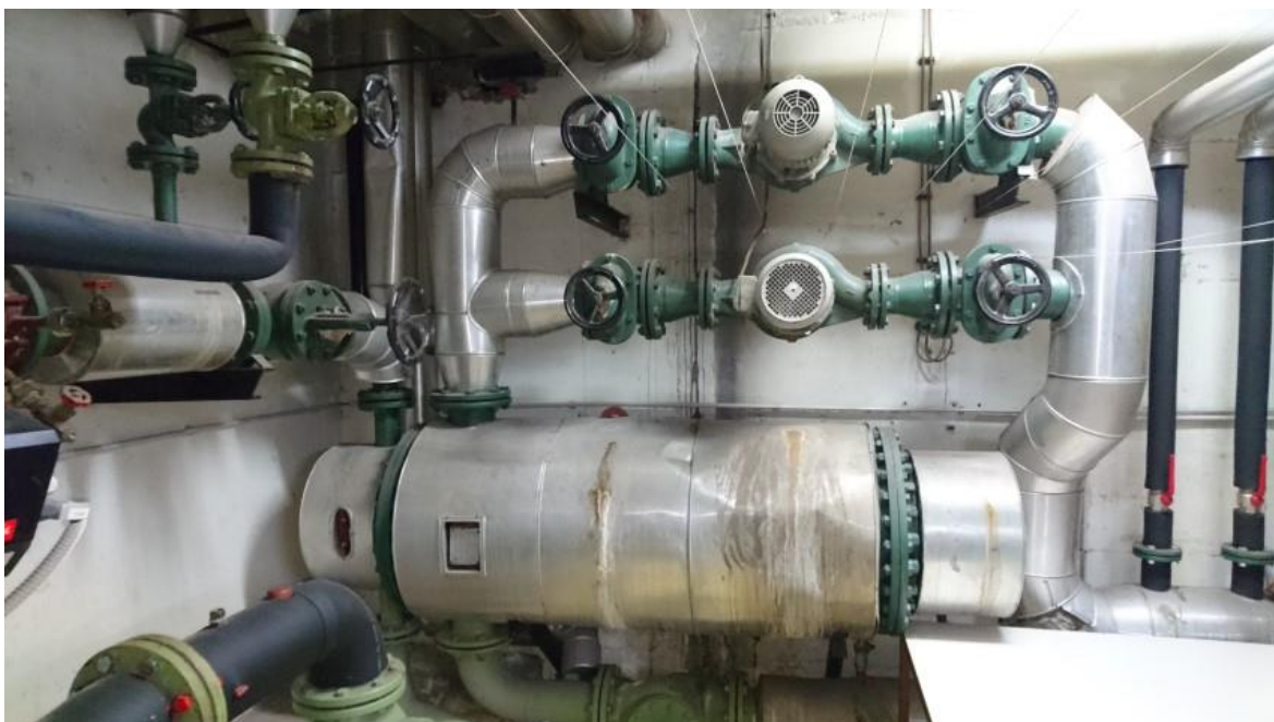
Slika 29: Spiralni prenosnik toplote obtočnimi črpalkami starejše izvedbe.
