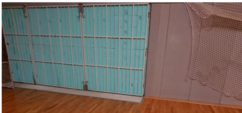
Slika 66: Izolirana vrata, ki pa ne prinesejo željenih rezultatov..
