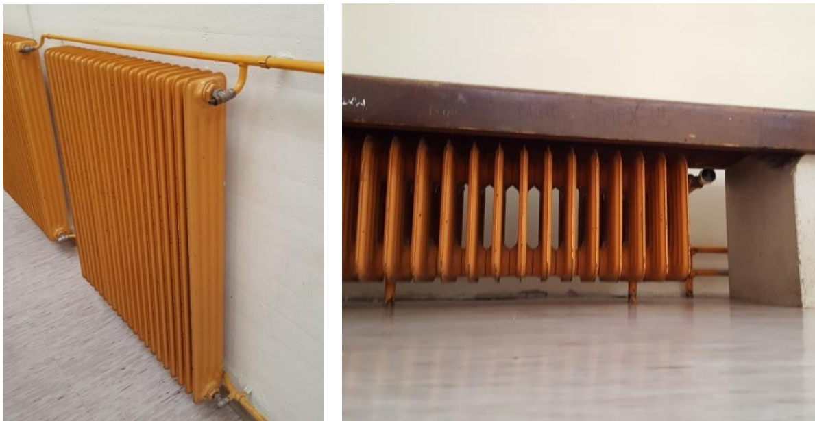
Slika 32: Litoželezni radiatorji brez ustreznih ventilov.
