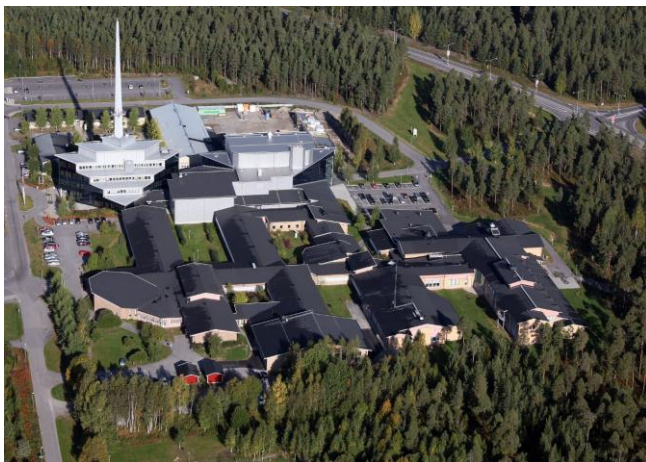
Den nya solcellsparken monteras på universitetets tak och kommer att ge ca 250 000 kWh förnybar energiproduktion.
