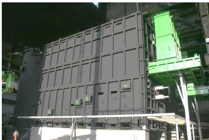
Nauji biokuro katilai Petrašiūnų elektrinėje.
