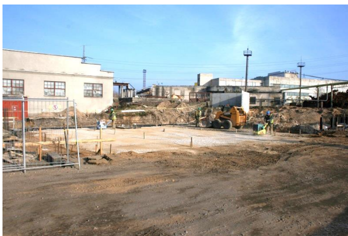
Įrengiamas biokuro sandėlis Petrašiūnų elektrinėje.
