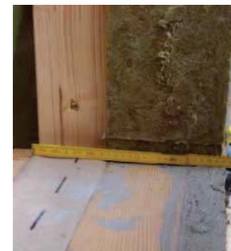
parete esterna dell'edificio, dove è visibile l'isolamento termico a cappotto esterno in lana di roccia da 16 cm, il pannello portante in Xlam da 10,5 cm ed i due correnti in legno (all'interno ed all'esterno) staffati alla parete che serviranno per sorreggere le due parti (interna ed esterna) della soglia in pietra della finestra.
