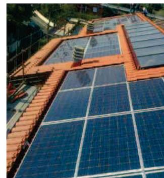
copertura con installati i collettori solari termici (16 m<sup>2</sup>) ed i moduli fotovoltaici (9,4 kWp)
